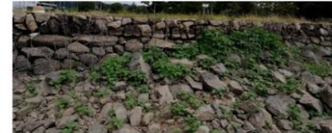
浮き石の押し込み作業が終了の後、上部を土盛り、土は池の粘土を使う。
